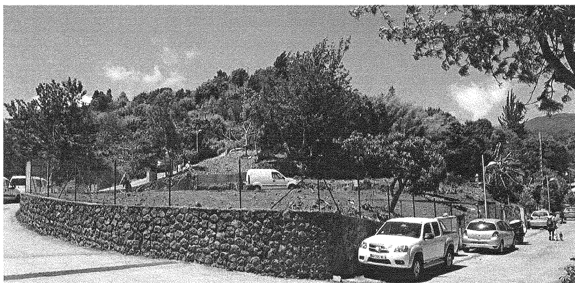
Photos des travaux de reprise / préparation plateformes réalisés en 2013
